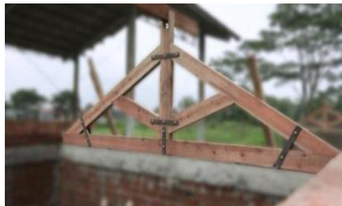
Gambar 3.12 Ikatan Antar Kuda-kuda dengan Plat Baja
