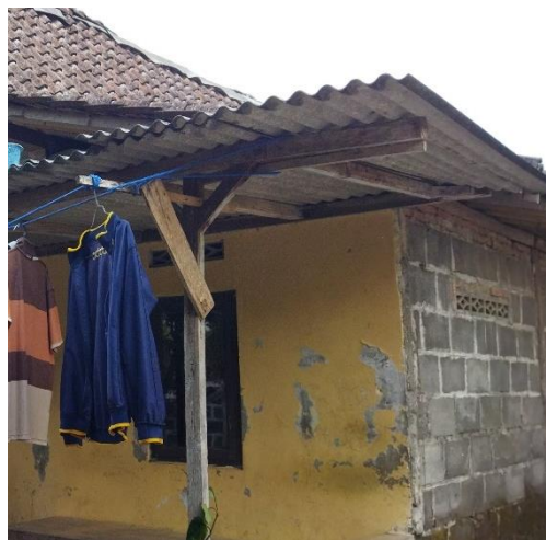
Gambar 5.51 Bangunan Tanpa Struktur Ringbalok
