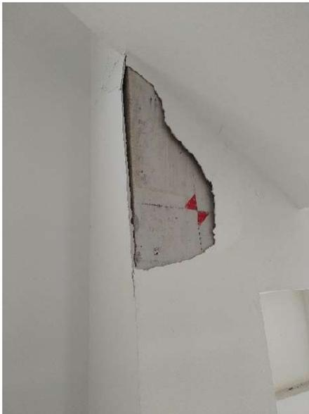
**Gambar L-13 Beton Kolom Terlihat**
