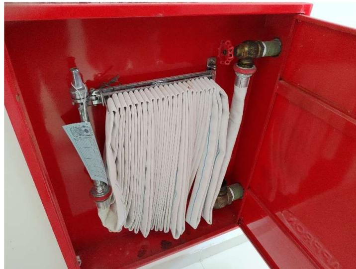
**Gambar 5.16** Pencatatan Inspeksi pada *Hydrant* Lantai *Basement*
