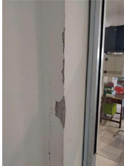
**Gambar 5.4 Kerusakan pada Plesteran dan Acian Dinding Lantai LG**
