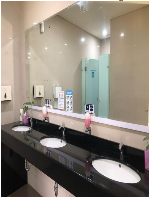
Gambar L-11.37 Washtafel di Toilet Stasiun LRT Palembang
