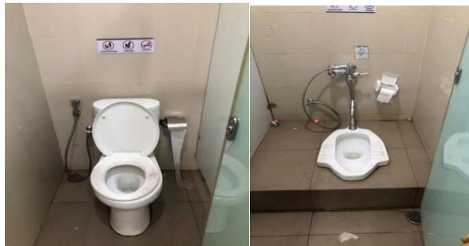
Gambar 5.31 Kondisi Toilet di Stasiun LRT Palembang
