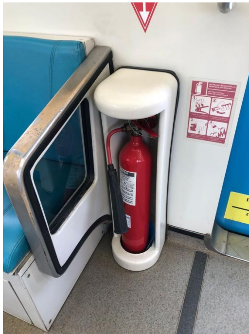
Gambar L-11.19 APAR di Kereta LRT Palembang
