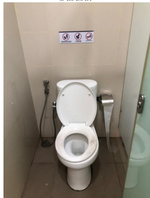
Gambar L-11.34 Toilet di Stasiun LRT Palembang
