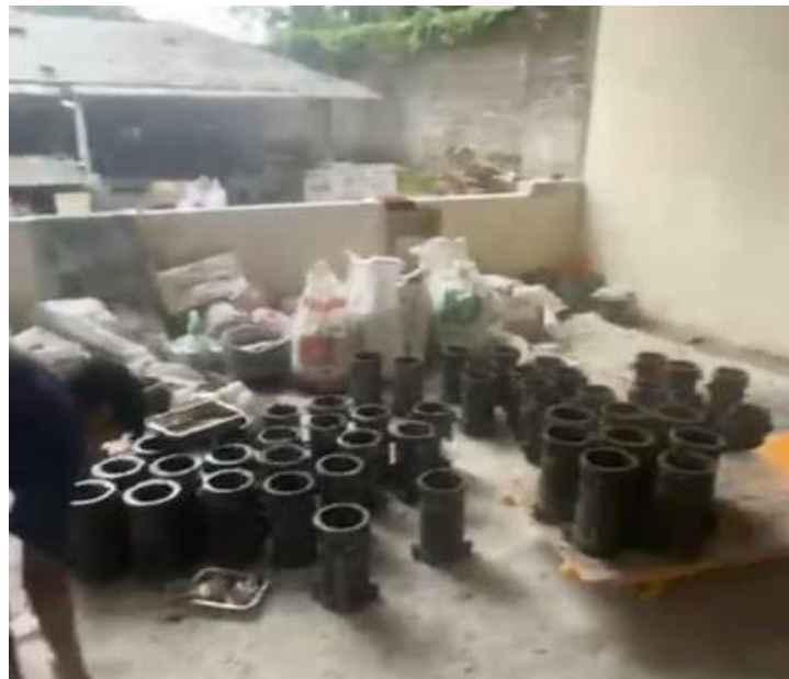
Gambar L8.2 Persiapan Cetakan Beton
