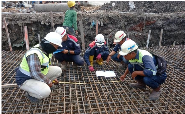
Gambar 3.6 Pembesian Pile Cap
