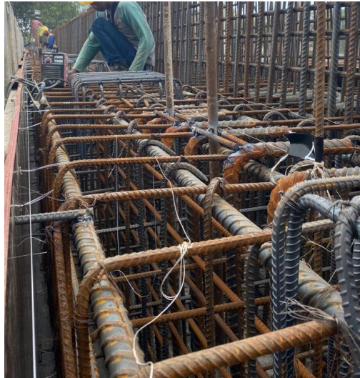
Gambar 5.5 Pekerjaan Penulangan Pier Head
