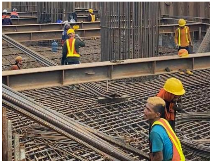
Gambar 5.3 Pekerjaan Penulangan Kolom
