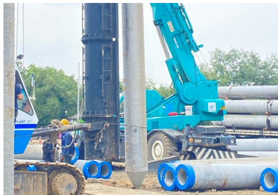
Gambar 5.1 Pekerjaan Pemancangan
