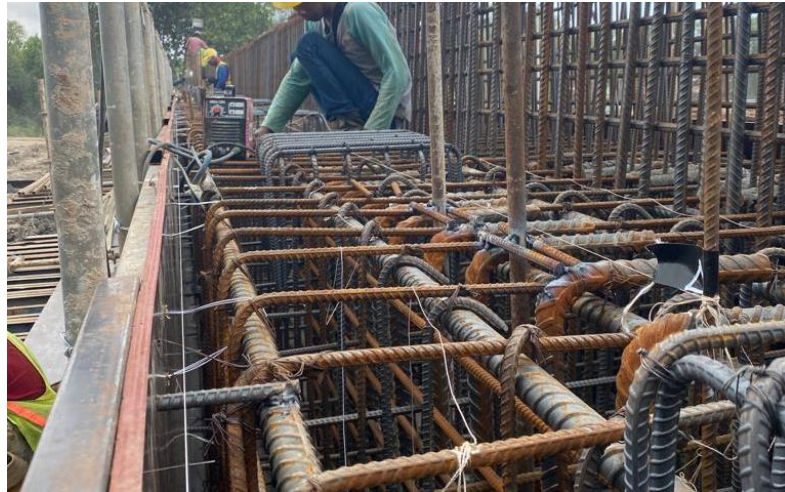
Gambar 3.8 Pekerjaan Penulangan Pier Head (Sumber: Dokumentasi Pribadi)
