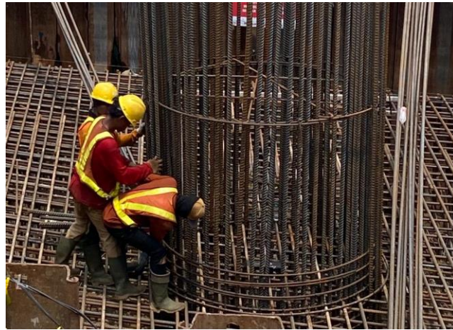
Gambar 3.7 Pekerjaan Penulangan Kolom
