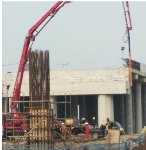
Gambar 5.4 Pekerjaan Pengecoran Kolom
