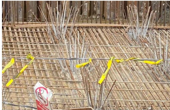
Gambar 5.2 Pekerjaan Penulangan Pile Cap (Sumber: dokumentasi pribadi)
