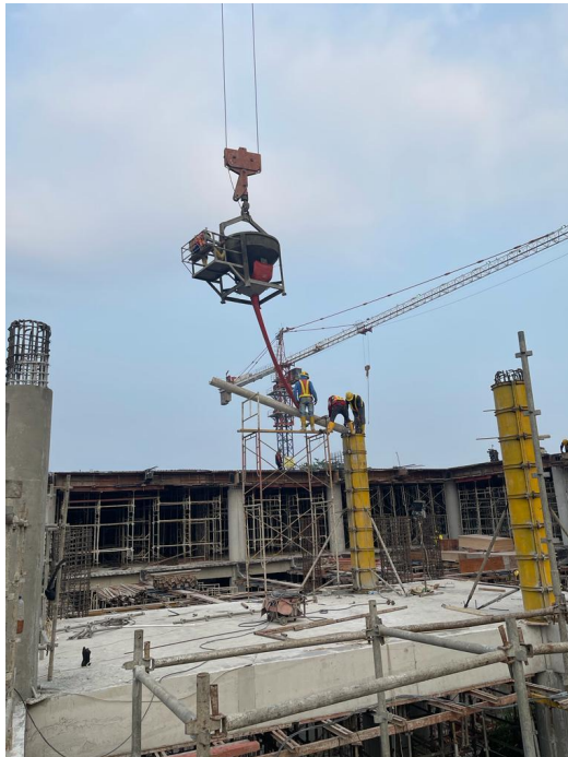
Gambar 5.10 Proses Penambahan Pipa Karena Lengan TC Sudah Tidak Sampai
