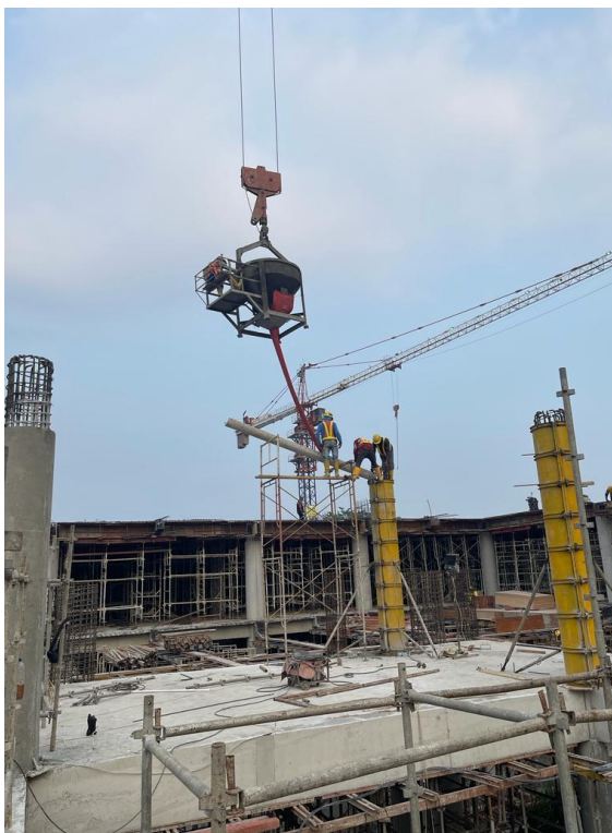
Gambar 5.1 Pengecoran Kolom Menggunakan CB Pada Proyek GIK UGM
