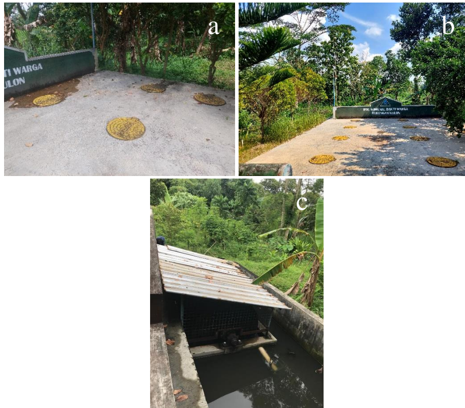
Gambar 11. kondisi IPAL Bakti Warga. kondisi bak anaerobic baffled reactor dan anaerobic filter dilihat dari atas manhole (a-b). Kondisi rotating biological contactor dan bak sedimentasi (c).
