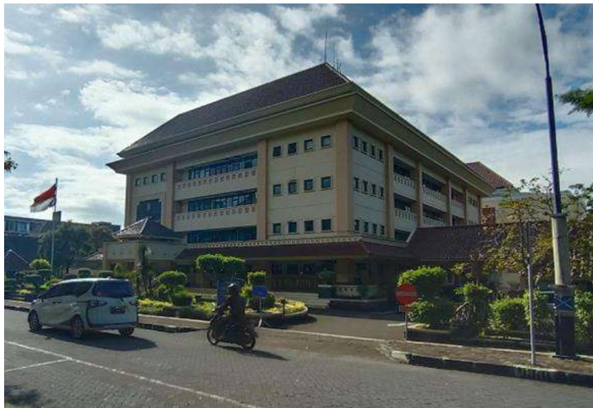
Gambar 1.2 Gedung Rektorat UII
