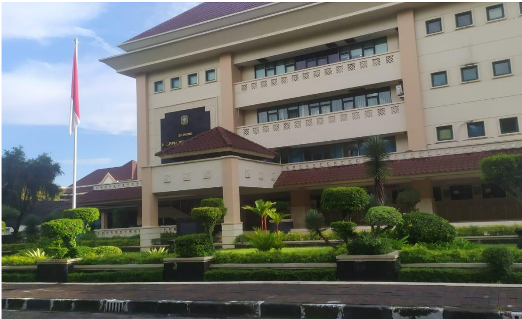
Gambar 1.1 Foto gedung direktorat pembinaan kemahasiswaan UII
