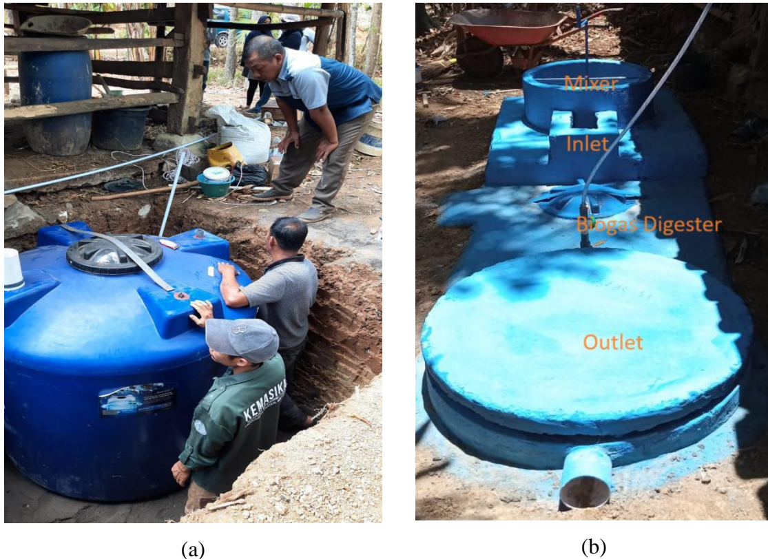
Gambar 6. (a) Proses Instalasi Biomiru (b). Biomiru yang selesai diinstal
