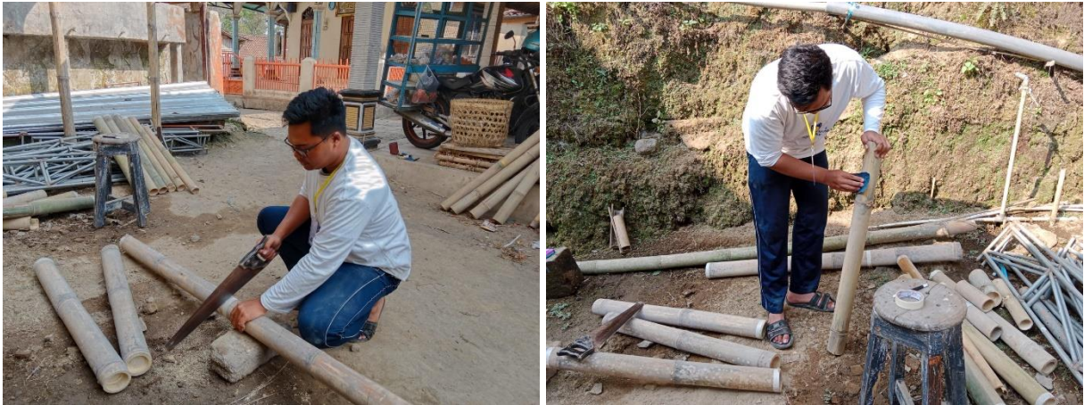
Gambar 5. Pemotongan dan pembersihan bambu
