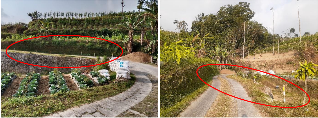
Gambar 7. Hasil pemasangan reflektor jalan
