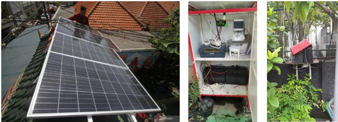
Gambar 1. Panel Surya, Inverter dan Baterai
