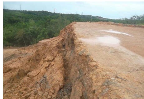
Gambar 1. Lereng di Proyek Pembangunan Pabrik Kariangau
