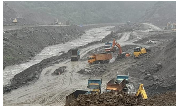
Gambar 2. Situasi pekerjaan galian Proyek Pembangunan Bendungan Bener Paket 4 (MYC)
