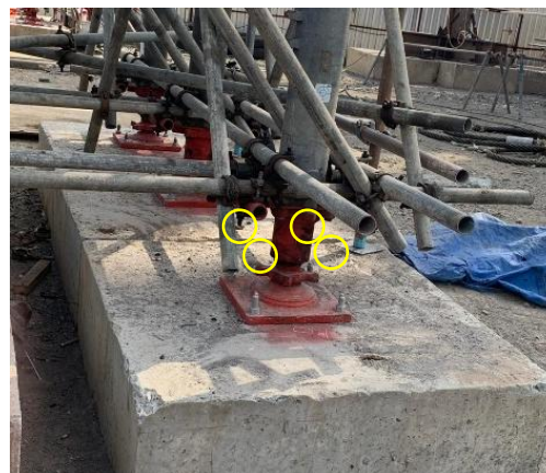
Gambar 1. Posisi baut dynabolt pada Shoring
