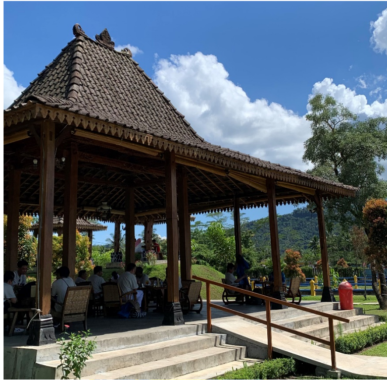
Balai Pertemuan (Sumber: dokumentasi)
