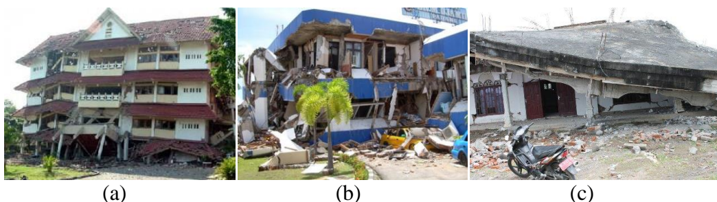
Gambar 1.1 Kerusakan Bangunan Akibat Gempa Bumi; (a) Gempa Yogyakarta 2006; (b) Gempa Padang 2009; (c) Gempa Aceh 2013
