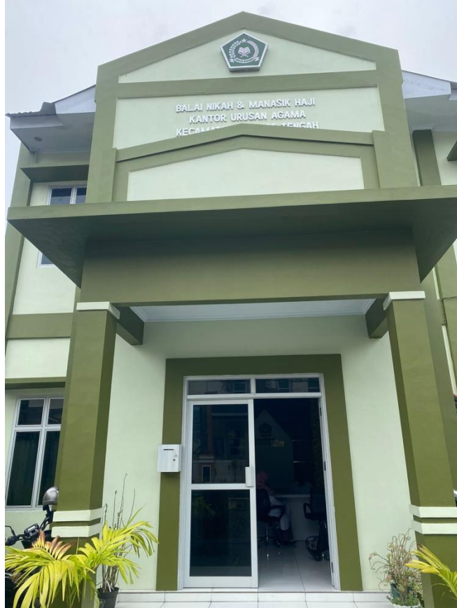
Gambar 2 Bangunan Kantor Urusan Agama Kec. Ternate Tengah
