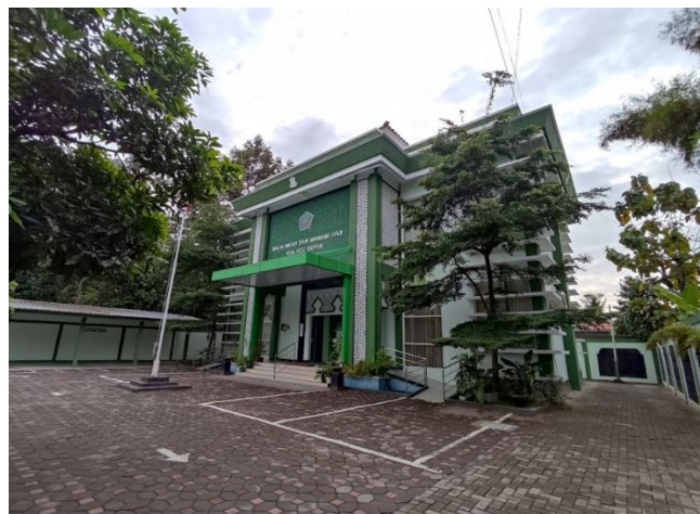
Gambar 10 Gedung KUA Kapanewon Depok
