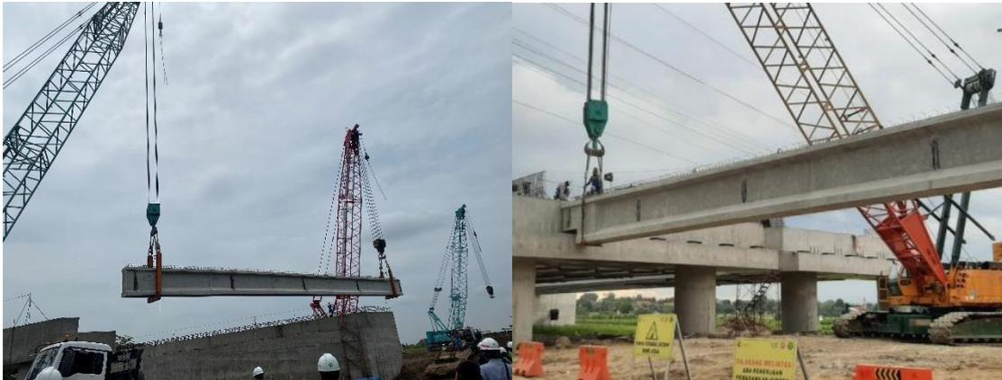
Gambar 4. 2 *Erection Girder* Menggunakan *Crawler Crane*
