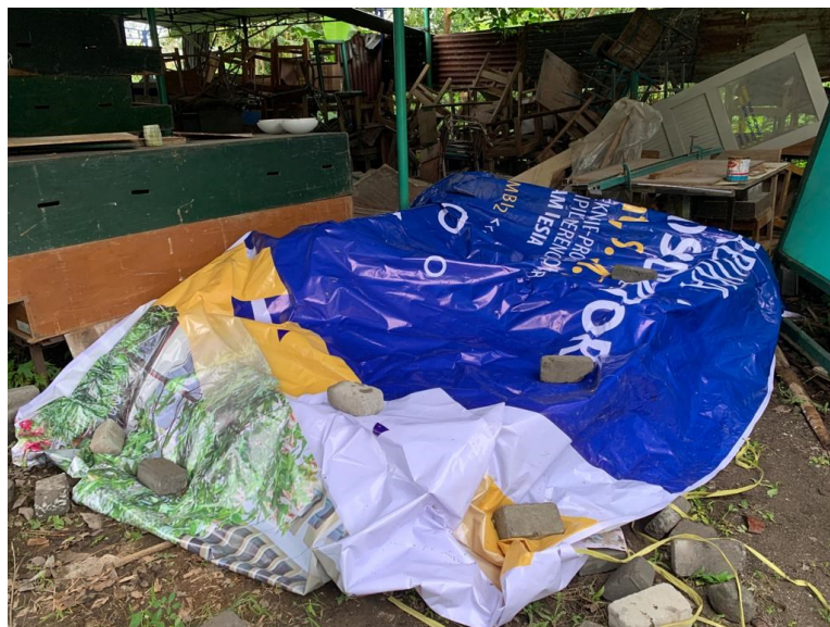
Gambar L-2.6 Penutupan Paving block Untuk Menjaga Kelembaban
