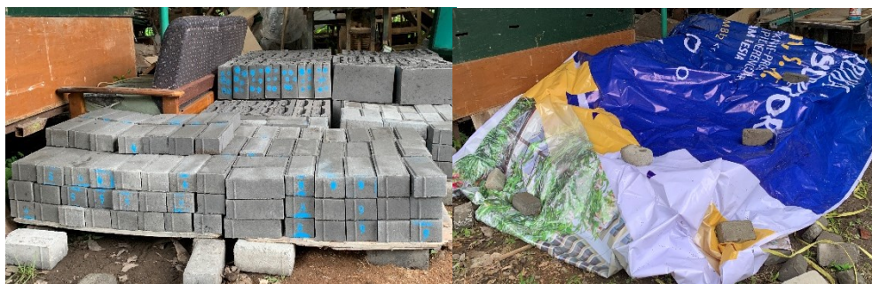
Gambar 4.21 Penumpukan dan Penutupan Paving
