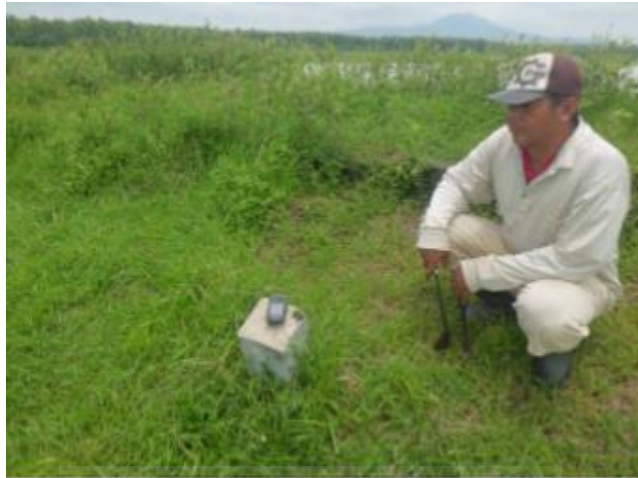
Gambar 1.2 Patok yang Miring Pada Lereng Hilir Tubuh Bendungan
