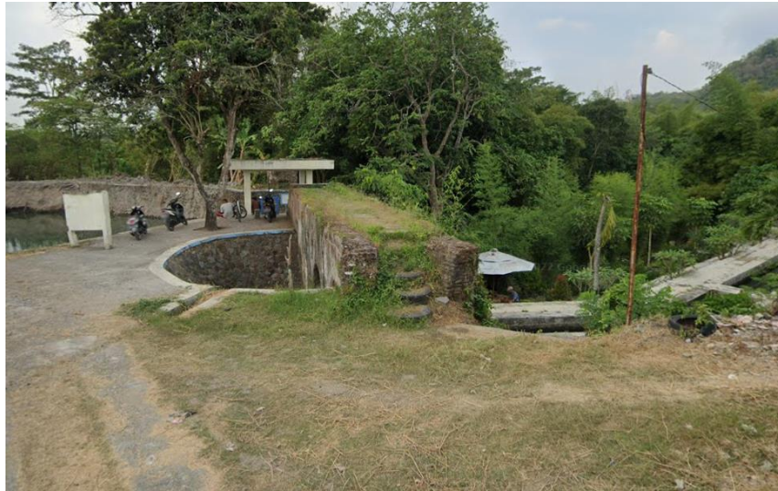
Gambar 5.1 Kondisi Titik 29 dengan Mayoritas Bangunan Beton
