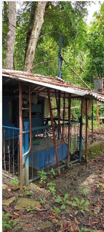
Gambar 4. 2 Instalasi Sumur Bor
