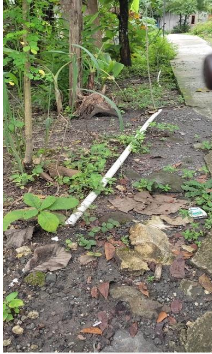
Gambar 4. 7 Pipa pada Ruas Jalan Desa Pamsimas
