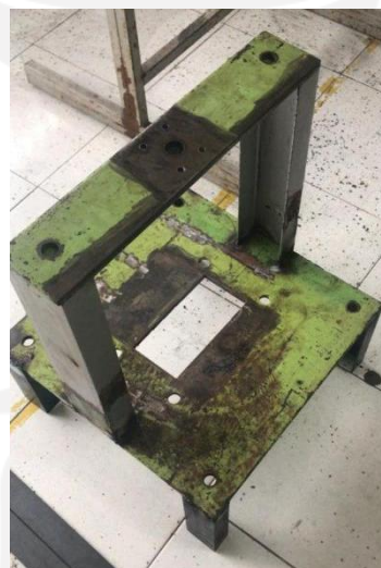
Gambar 4- 13 Hasil frame yang sudah di las
