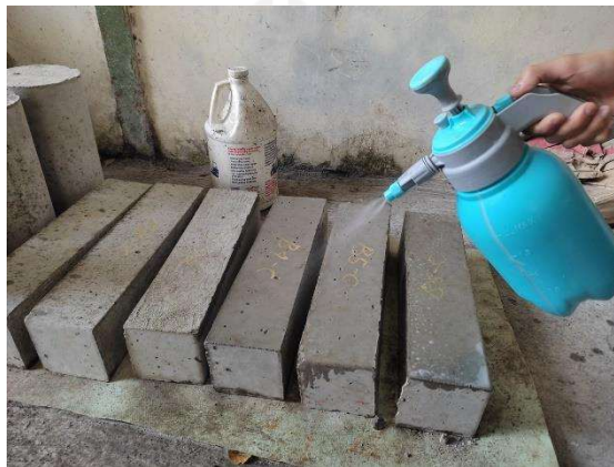
Gambar 4. 3 Perawatan beton dengan disemprot curing compound
