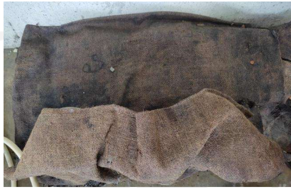
Gambar 4. 2 Perawatan beton dengan ditutup karung goni basah
