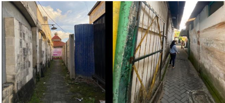
Gambar 4. Bentuk dan Massa Bangunan Sumber: Dokumentasi Pribadi, 2022
