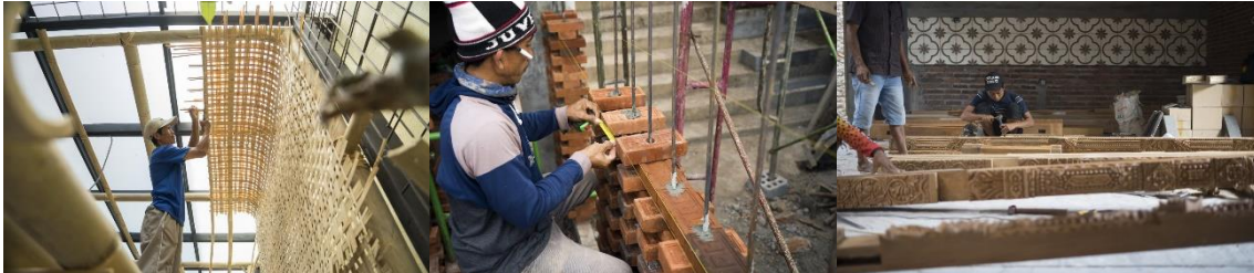
Gambar 1 (dari kiri ke kanan) Proses pembangunan “ Omah Boto ” karya Arsitek Andy Rahman dengan melibatkan para pekerja dan pengrajin lokal anyaman, batu bata, hingga ukiran.
