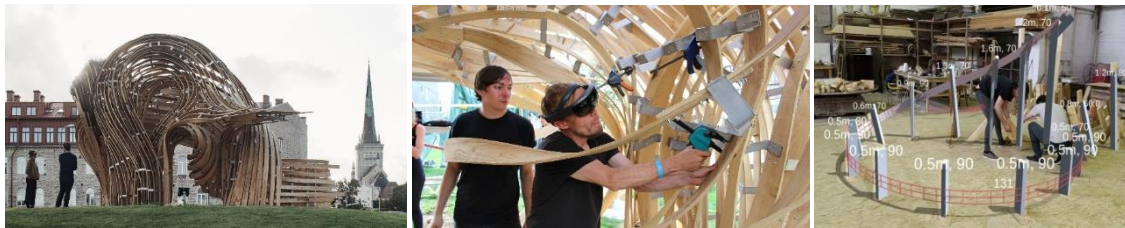
Gambar 16, 17, dan 18 Proses assembly menggunakan bantuan sistem perangkat immersive technology .
