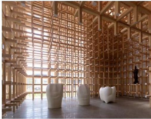
Gambar 4 Konstruksi batang-batang kayu dalam rakitan terpisah ( discrete assembly ) pada GC Prostho Museum Research Center di Jepang, karya Arsitek Kengo Kuma Sumber: www.archdaily.com
