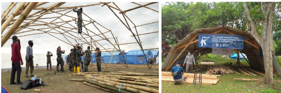
Gambar 2 dan 3 Konstruksi shelter berbahan bambu dan kayu lokal dengan melibatkan bantuan masyarakat setempat dan relawan.
