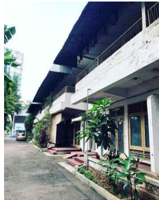
Gambar 3 Bangunan eksisting rumah pegawai Peruri (sebelum direnovasi pada tahun 2019)
