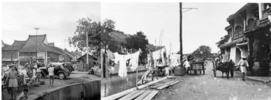
Gambar 7. Kondisi Pejagalan, Penjaringan sebelum urbanisasi pada tahun 1915-1949
