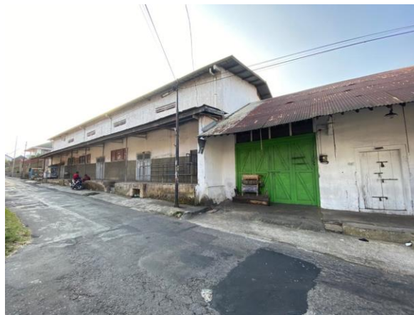
Gambar 12 : Bentuk fasade bekas gedung bioskop yang masih menggunakan langgam arsitektur china
