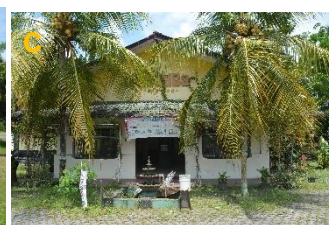
Bangunan Kafe DgondangBa
