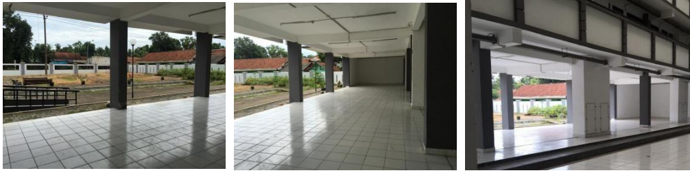
Gambar 3. Ruang komunal terbuka Rusunawa Bayem Sumber: Dokumentasi Pribadi
