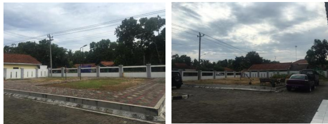
Gambar 4. Ruang komunal outdoor Rusunawa Bayem Sumber: Dokumentasi Pribadi
