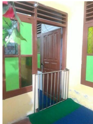
Gambar 6. Pintu Masuk TPA
