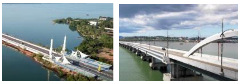
Gambar 2. Area Parkir & Kantilever Pedestrian Bawah Jembatan Dompok (Sumber: Penulis, 2020)
