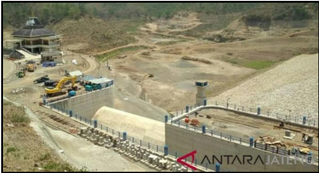
Foto Lokasi pembangunan Bendungan Bener.
