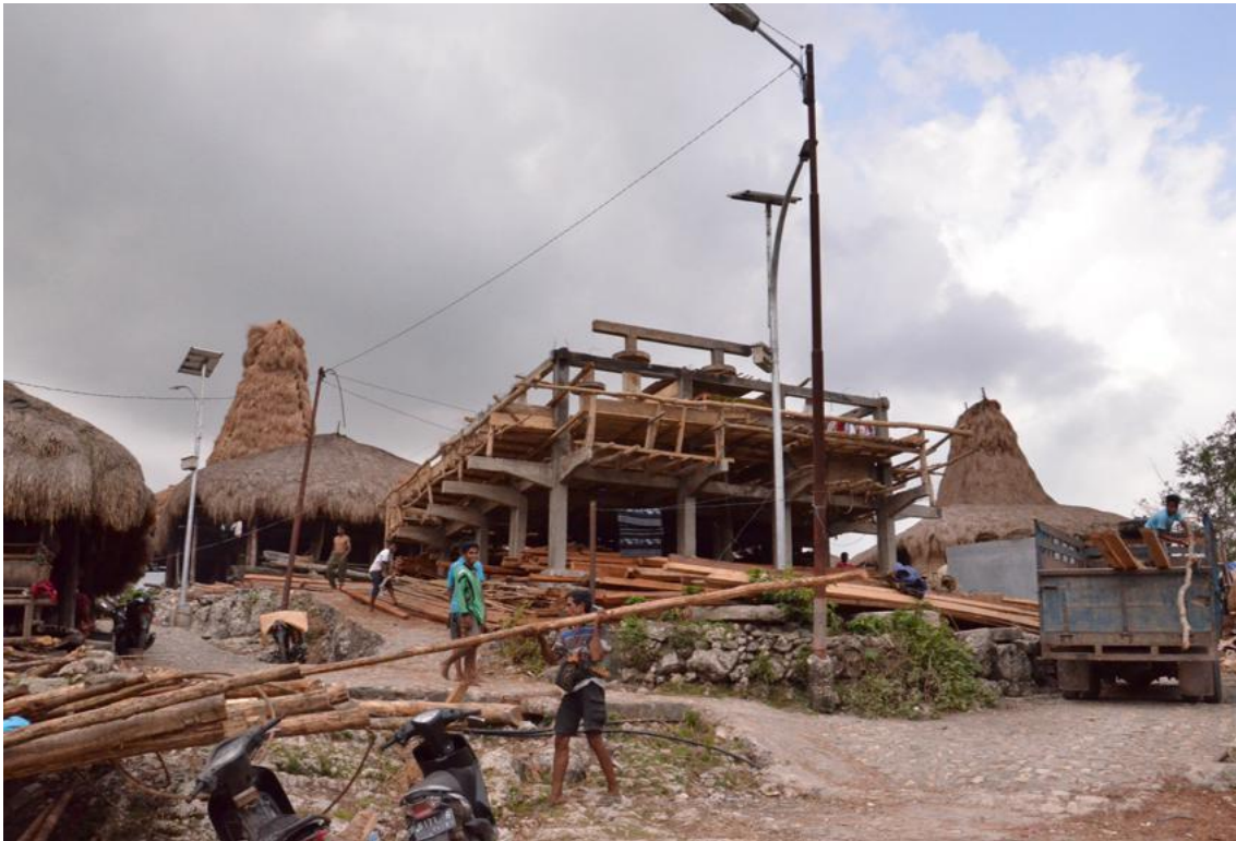
Gambar 2. Foto substitusi material beton pengganti kayu
