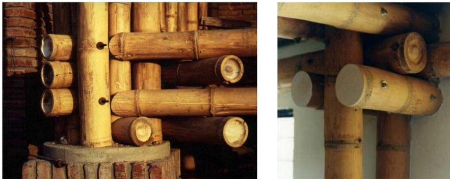
**Gambar 6** Sambungan Modern dengan Dukungan Mur dan Baut
