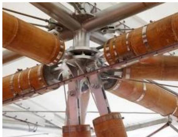
**Gambar 7** Sambungan Modern dengan Dukungan Plat Baja
