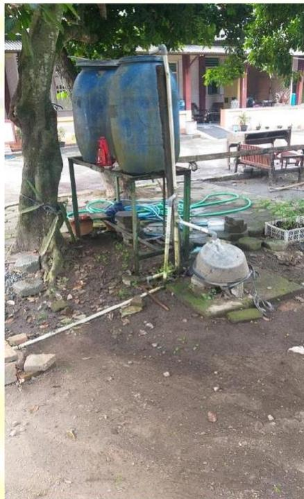
Gambar 4.10 Sumur Jet Pam dan Toren Air
