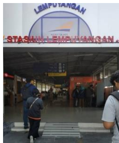
Gambar 6. Ramp yang menjadi akses antara Hall dan Area Parkir. Sumber: Hasil Penelitian tahun 2019
