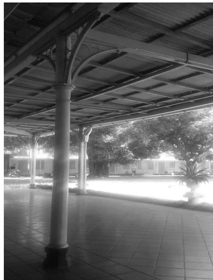
Gambar 5. Kolom besi baja yang dipakai untuk menyangga atap teritisan pondapa.
