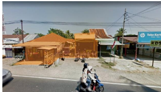
Gambar 3. Tampak Bangunan Eksisting
