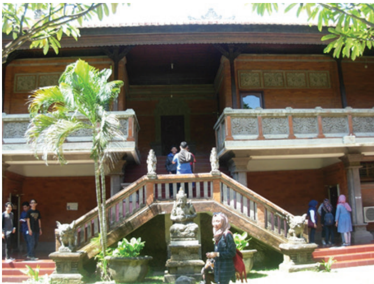
Gambar 2. Gedung Badung Sumber: Dokumentasi penulis.
