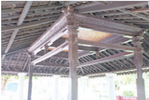
Gambar 7. Sistem sambungan balok dan kolom tumpang sari Sumber: Penulis, 2016
