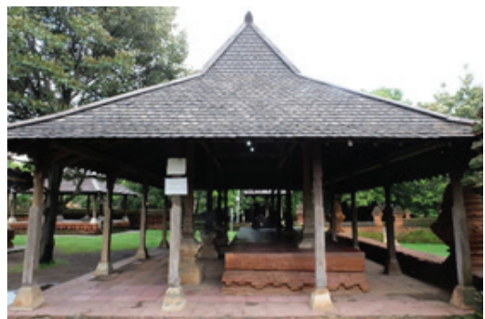
Gambar 6. Keramik sebagai penutup lantai Sumber: Penulis, 2016
