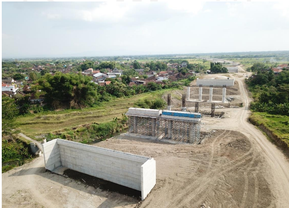
Gambar L-4.1 Proyek Pembangunan Jalan Tol Soo-Yogyakarta-NYIA
