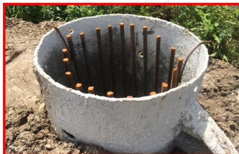
8. Keranjang besi tulangan sudah terpasang
