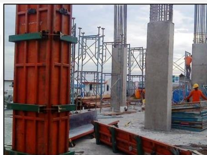
Pembuatan Struktur Kolom
