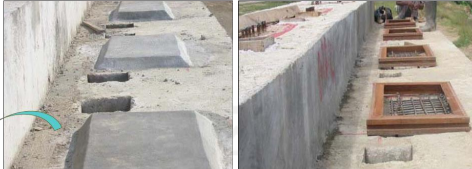
Pemasangan perletakan Elastomer sesuai elevasi dan posisi didalam gambar rencana
