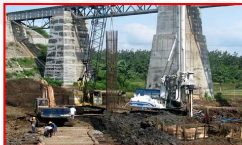
6. Pemasangan besi tulangan Crane Service
