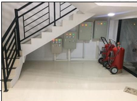
Pemasangan Panel Listrik
