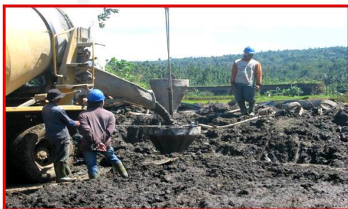
11. Pengecoran dengan truck mixer dan Tremie sebagai talang kedalam lubang bor
