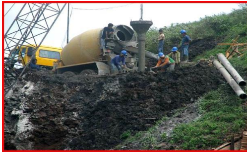
9. Pemasangan Pipa Tremie kedalam lubang bor dengan menyatel panjangnya
