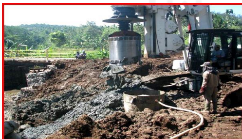
5. Pengeboran dilanjutkan dengan Drilling Bucket
