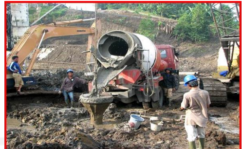
10. Proses pengecoran fondasi sampai 1 m diatas rencana cut of pile
