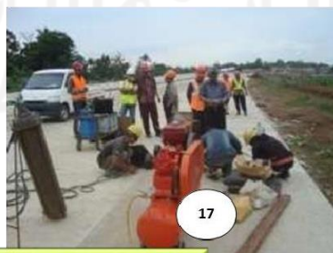
Pemanasan bahan joint sealent
