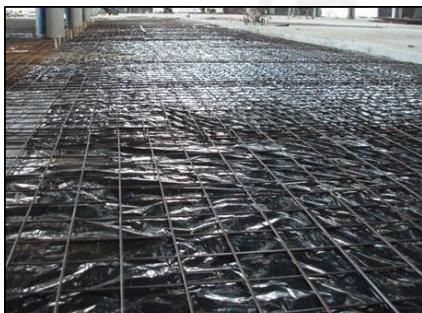
Pembuatan lantai dengan Wiremesh
