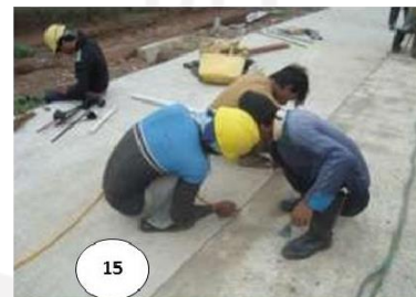
Pembersihan celah dengan compressor
