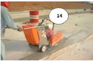
Cutting Beton dengan Alat "Concrete Cutter" setiap jarak 5m ; sedalam 4 ~ 6.5 cm ; lebar 6-10 mm ; dilakukan 8 s/d 10 jam setelah pengecoran berakhir.
