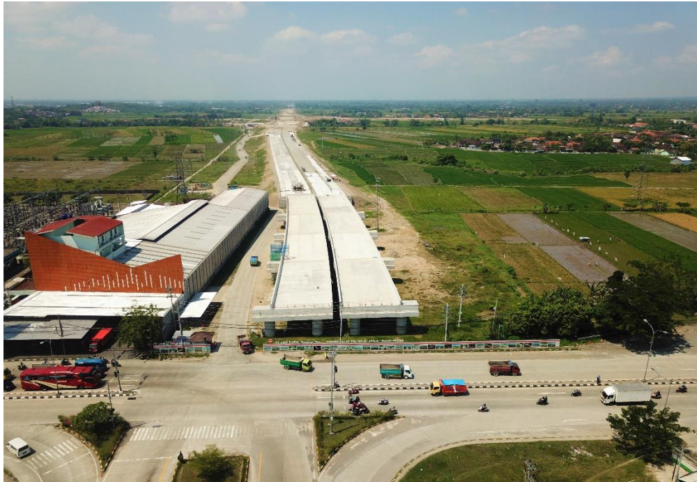
Gambar L-4.1 Proyek Pembangunan Jalan Tol Soo-Yogyakarta-NYIA
