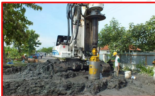
7. Bersihkan lumpur dengan Cleaning Bucket
