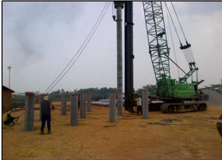
Pemancangan Spun pile
