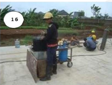
Cutting Beton dengan Alat "Concrete Cutter" setiap jarak 5m ; sedalam 4 ~ 6.5 cm ; lebar 6-10 mm ; dilakukan 8 s/d 10 jam setelah pengecoran berakhir.
