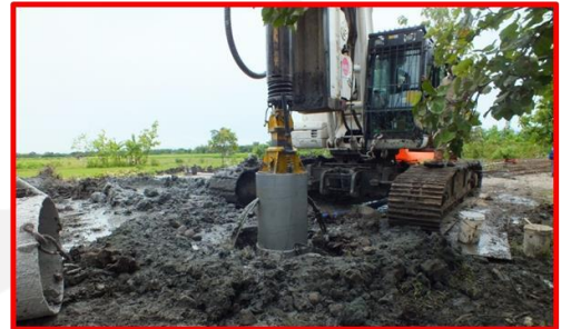
12. Tarik casing bored pile setelah pengecoran selesai
