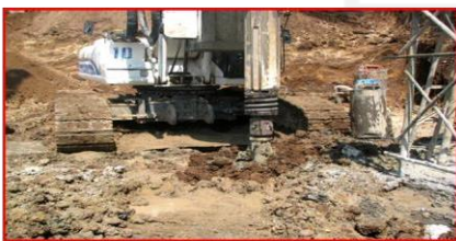
1. Tandai titik bored pile, lalu mulai pengeboran dengan Auger
