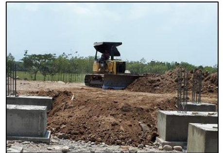
Pembuatan Sloof dan pengurugan tanah
