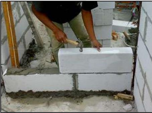
Pemasangan Dinding Hebel
