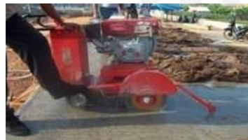
Cutting Beton dengan Alat "Concrete Cutter" setiap jarak 5m ; sedalam 4 ~ 6.5 cm ; lebar 6-10 mm ; dilakukan 8 s/d 10 jam setelah pengecoran berakhir.
