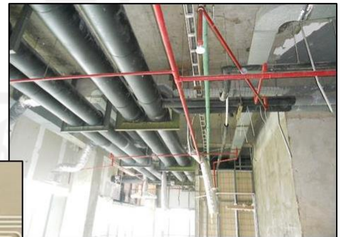
Instalasi plumbing air kotor dan air bersih
