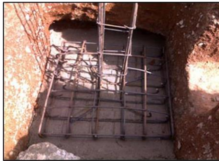
Pembuatan Pondasi Footplate
