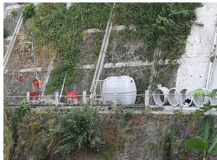
Gambar 30 Pengerjaan septictank komunal
