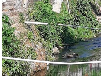
Gambar 17 Saluran drainase PVC, Terban
