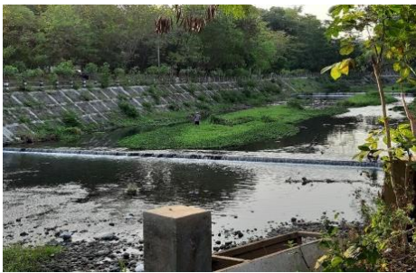
Gambar 26 Kondisi bendungan, Sinduadi
