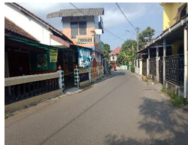
Gambar 4 Kondisi Jalan Dalam Kampung
