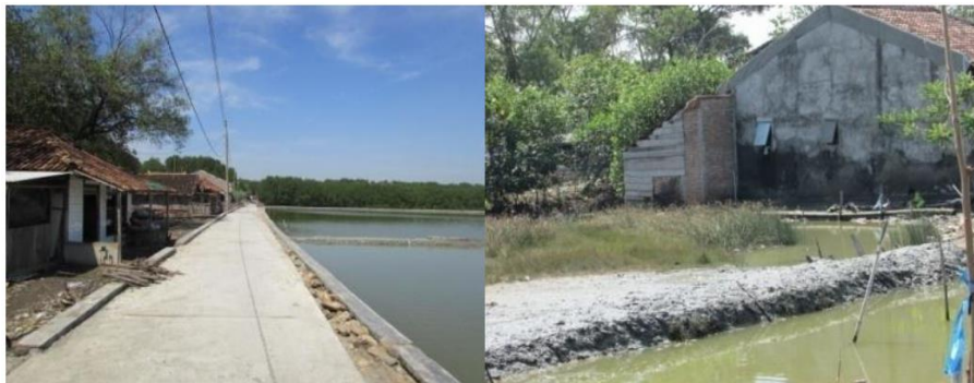
Gambar 3 Kondisi jalan di Morodemak
