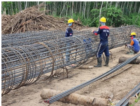
Gambar L-1. 4 Prose Perakitan Tulangan
