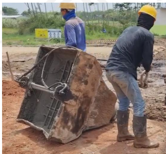
Gambar L-1. 5 Proses Pemasangan Kawat Seling
