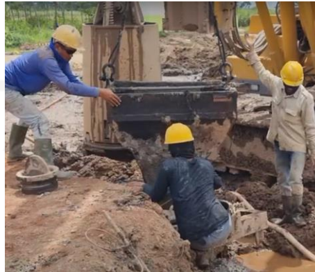
Gambar 5. 4 Pekerja Tergores Saat Membuka Concrete Bucket
