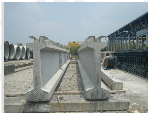
Gambar 3.1. Balok Girder Tipe PC-I
