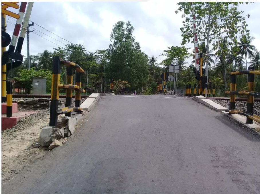
Gambar 5. 4 Foto Lokasi Pekerjaan Flyover (sumber: dokumentasi pribadi)
