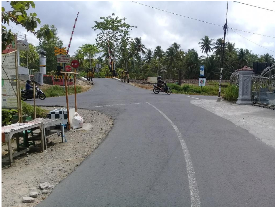
Gambar 5.3 Foto Lokasi Pekerjaan Flyover (sumber: dokumentasi pribadi)
