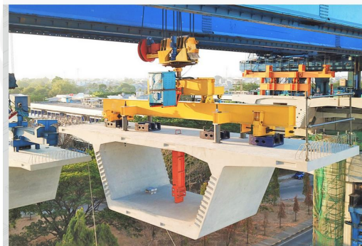
Gambar 3.2 Balok Girder Tipe Box Girder
